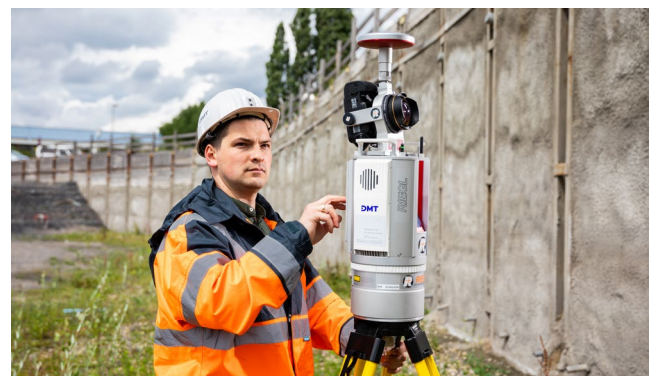
Scanning einer Baugrube: Volumen- und Zustandsbestimmung
