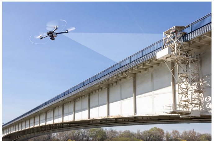
UAV-Vermessung: as-built Dokumentation und Inspektion von Brücken
